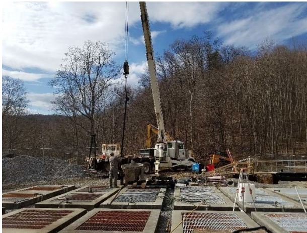
Clarifier Foundation Pour
