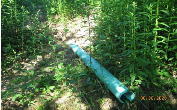
Luzerne Mine Discharge Pipe
